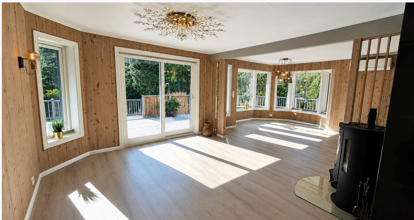
Nye gulv og vegger av norsk limtrepanel.
