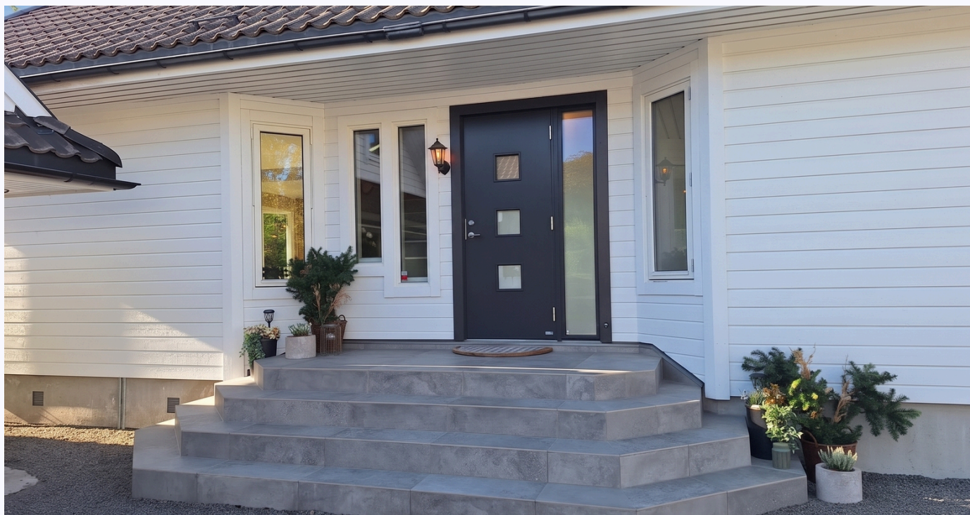
Flislagt inngangsparti med ny ytterdør.
