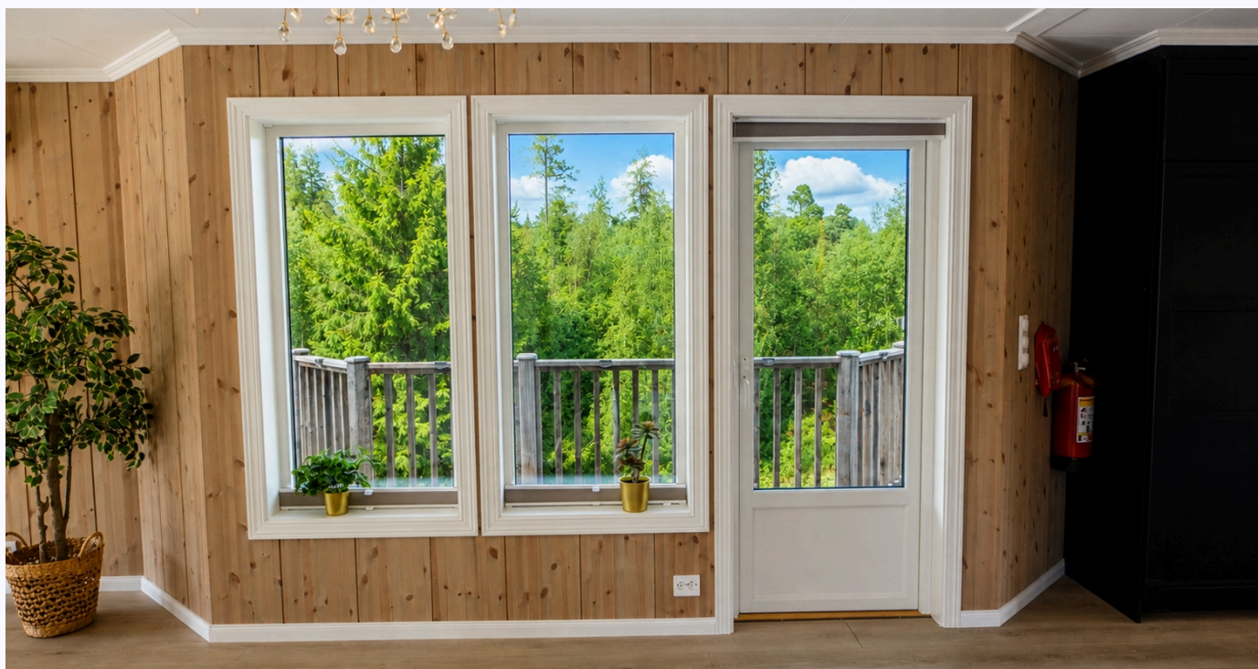
Balkongdør ut til veranda på nordsiden
