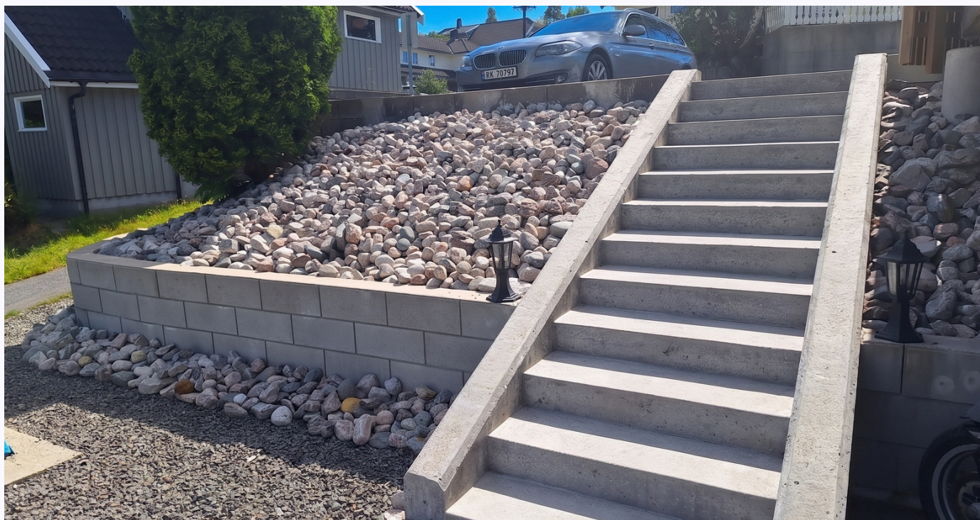
Flott vedlikeholdsfri betongtrapp.
