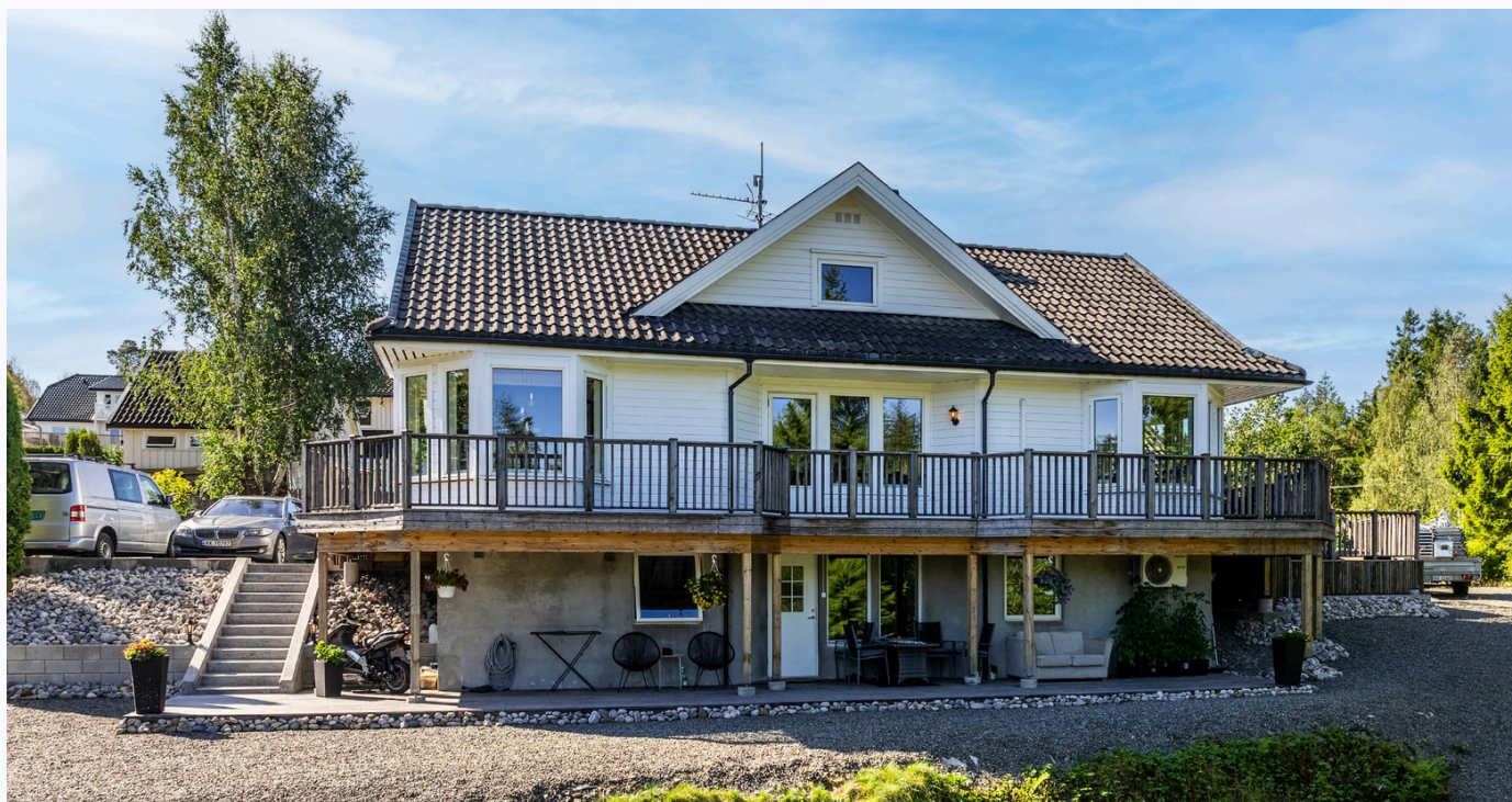
Huset er nymalt med unntak av grunnmur
