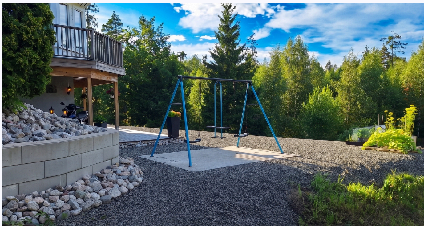
Støpt platting tiltenkt utebod for leilighet
