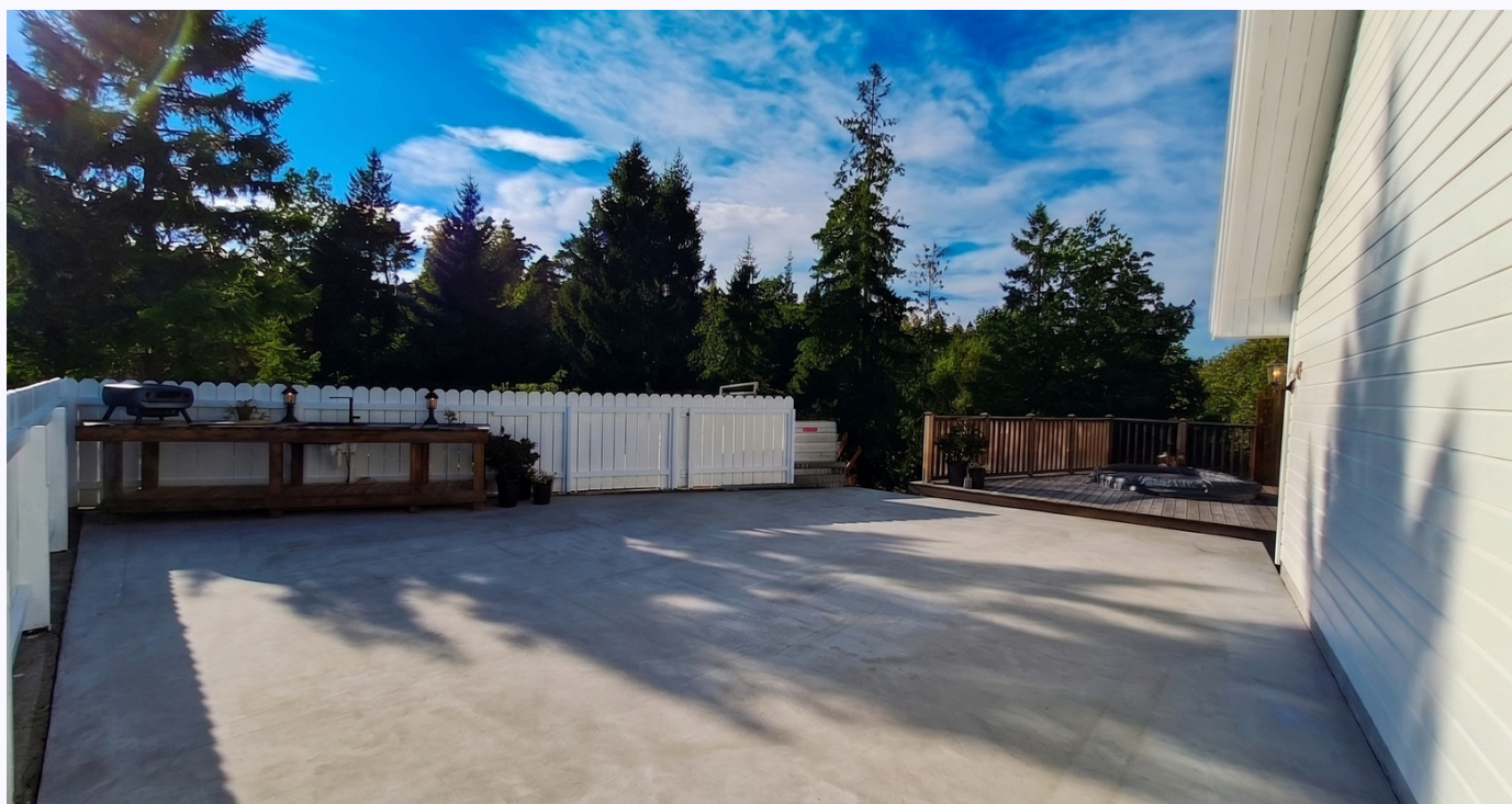
Stor betongplatting på 50 kvm
